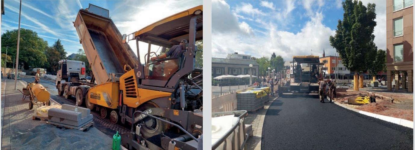
Bild 9: Impressionen vom Asphalteinbau des AC 16 B S
