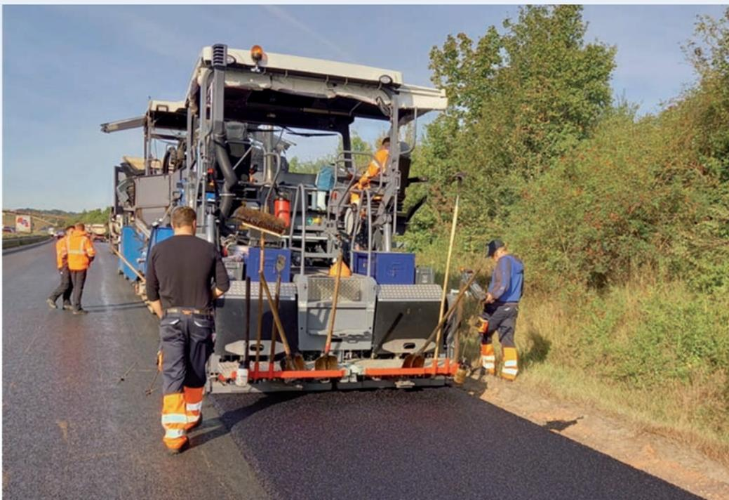
Bild 1: Einbau des mit dem Bitumenadditiv B2Last versetzten Splitt-Mastix-Asphalts auf dem Standstreifen der A 63
