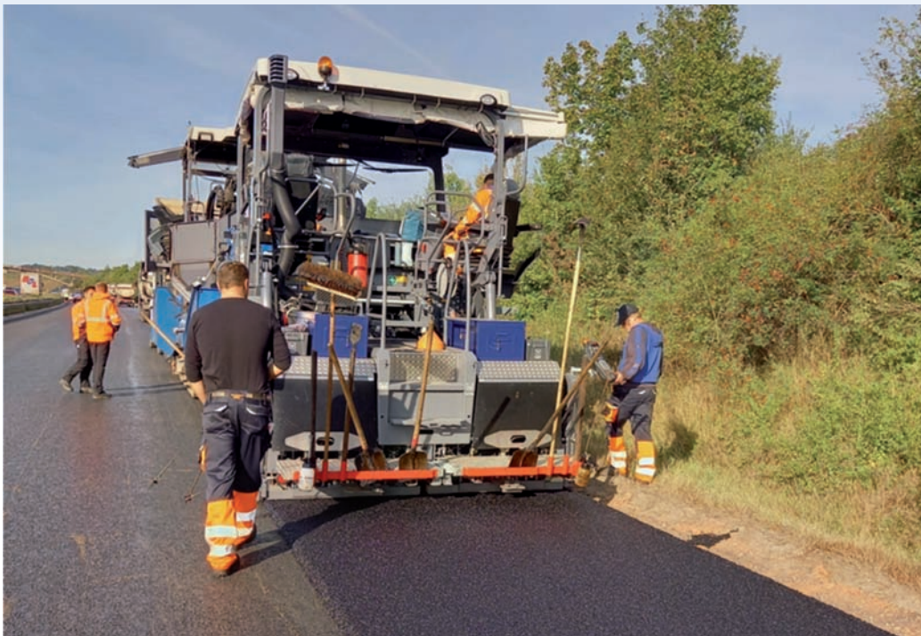
Bild 1: Einbau des mit dem Bitumenadditiv B2Last versetzten Splitt-Mastix-Asphalts auf dem Standstreifen der A 63
