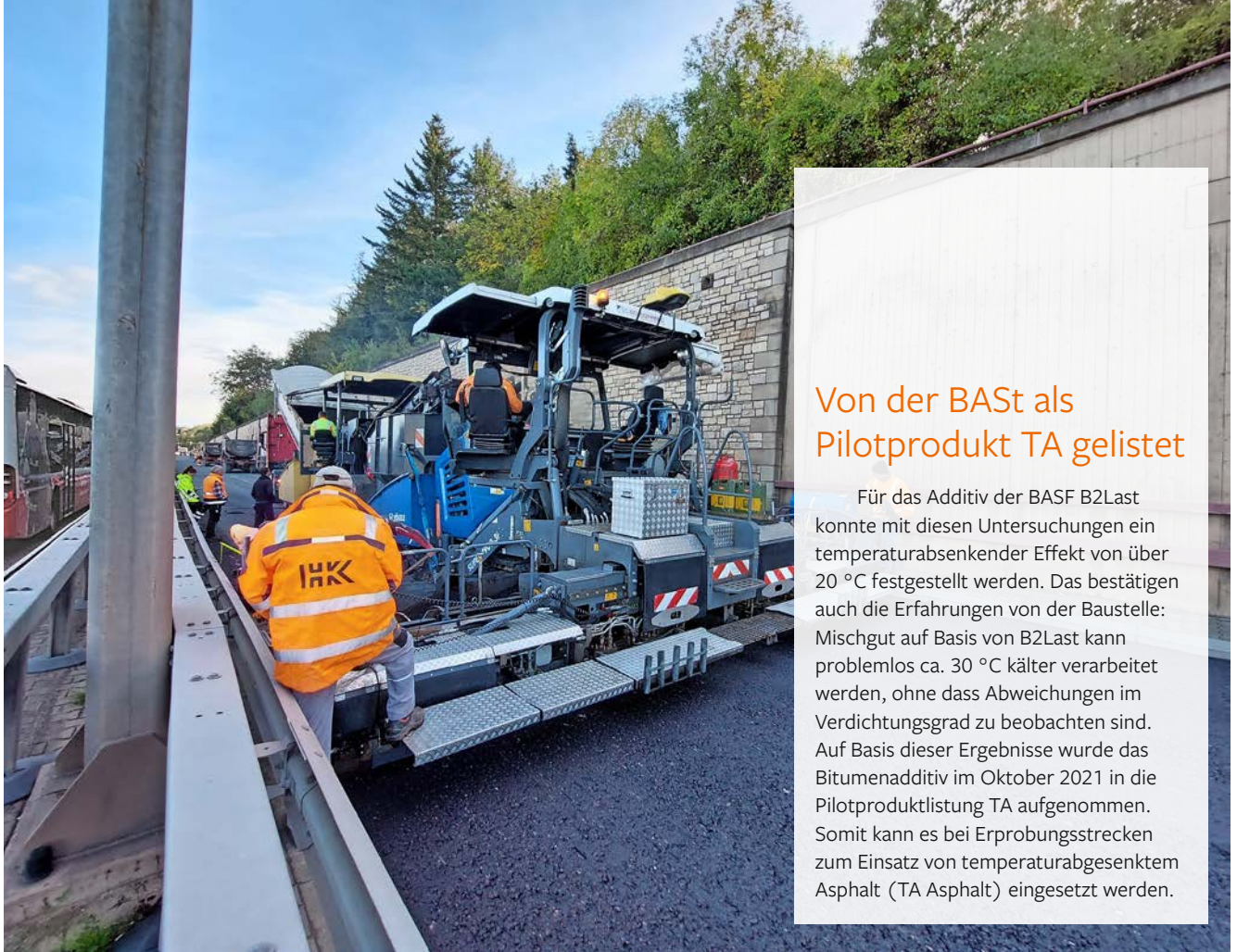
Bild 1: Einbau auf der Erprobungsstrecke
