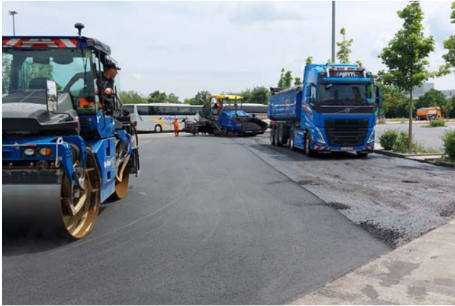
Einbau auf dem werkseigenen Busbahnhof
