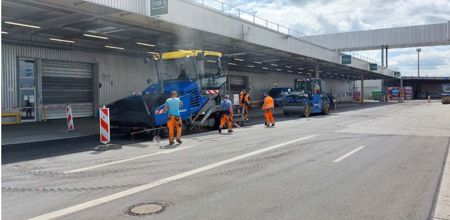
Einbau des Asphaltmischgutes an einer Lkw-Entladezone.
