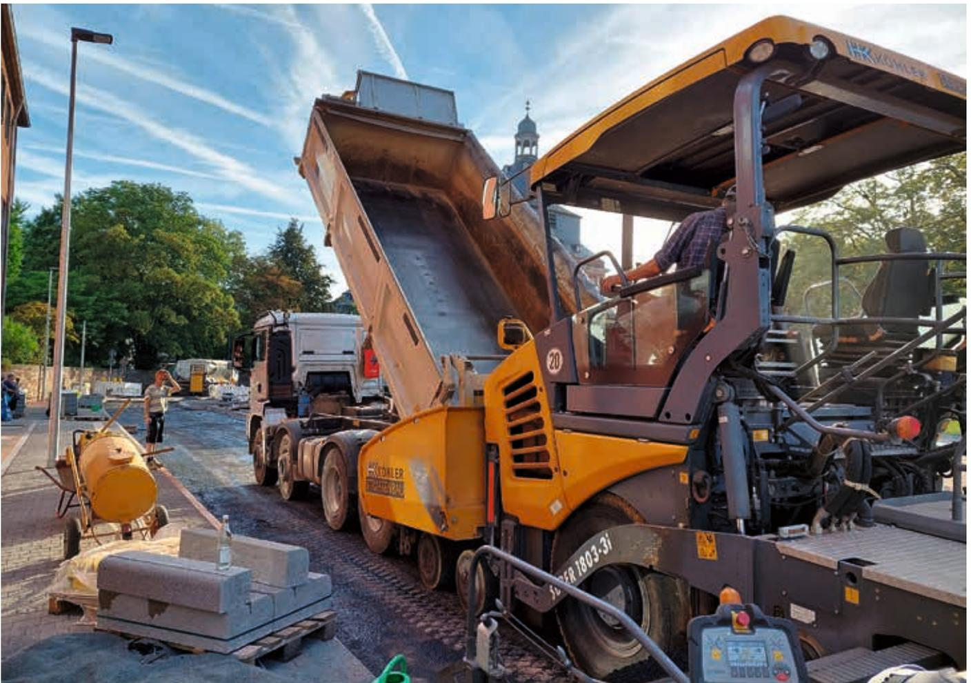
Das Asphaltmischgut wurde bei Temperaturen von 150–160 °C (gemessen an der Fertiger-Bohle) ohne Auffälligkeiten verarbeitet.
